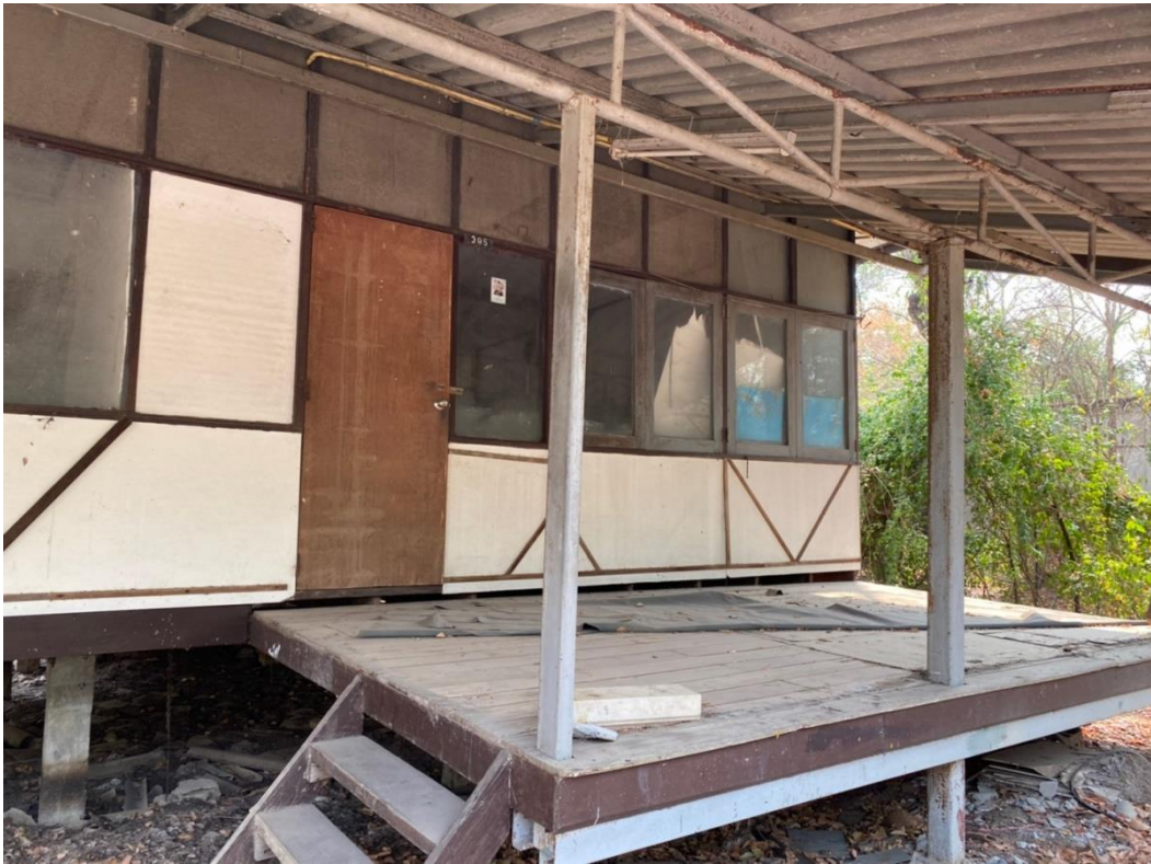
บ้านหลังที่ ๕ บ้านพักอาศัย ลำดับทะเบียนที่ราชพัสดุ ๗๑ (บ้านเลขที่ ๑๑๘๐)
