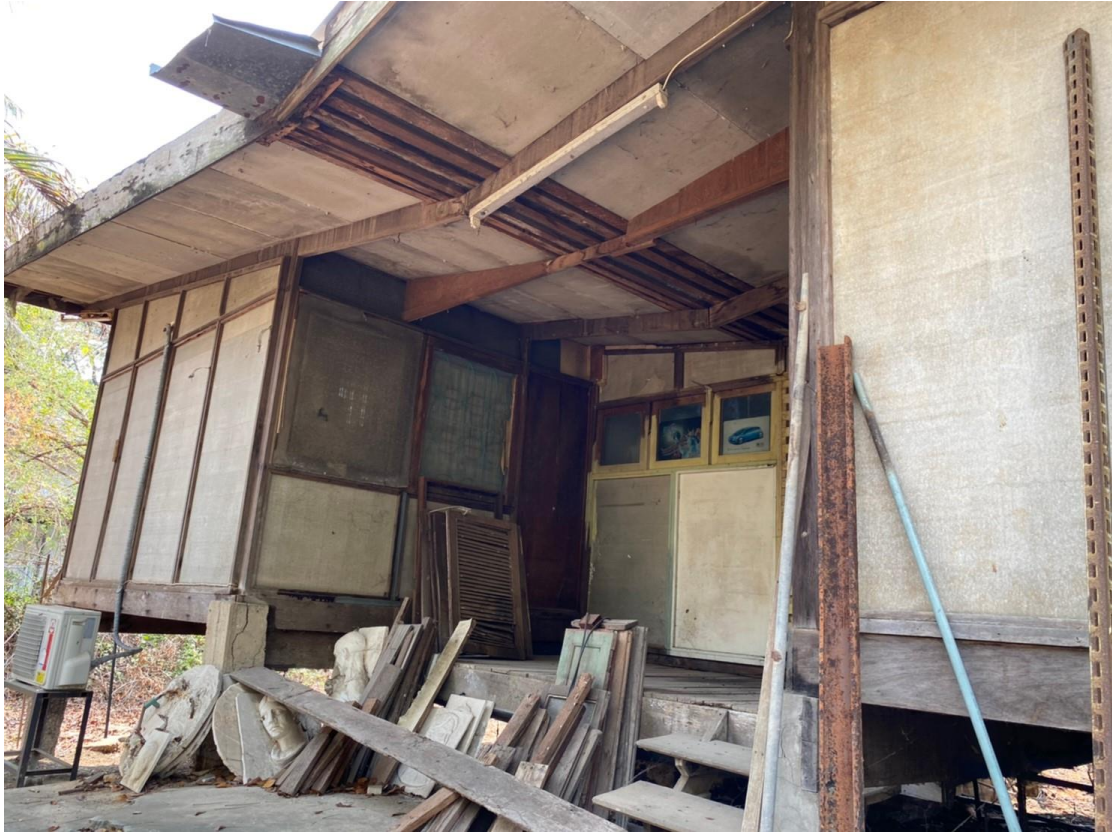
บ้านหลังที่ ๒ บ้านพักอาศัย ลำดับทะเบียนที่ราชพัสดุ ๖๘ (บ้านเลขที่ ๑๑๗๔)
