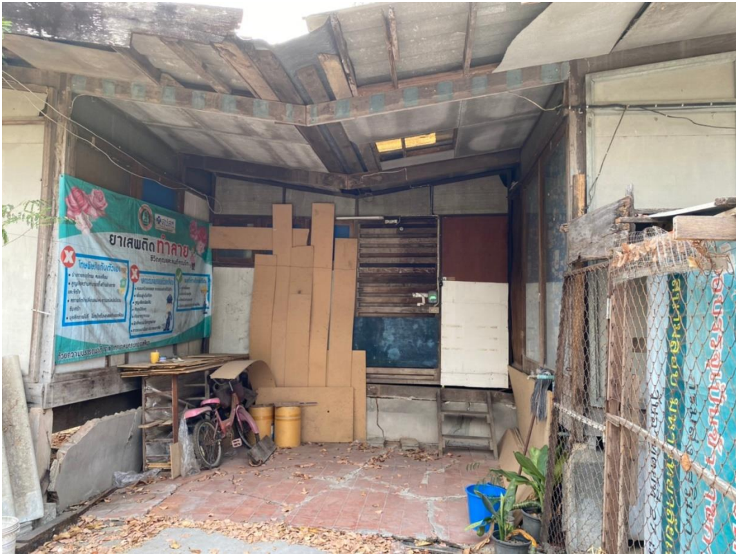
บ้านหลังที่ ๓ บ้านพักอาศัย ลำดับทะเบียนที่ราชพัสดุ ๖๙ (บ้านเลขที่ ๑๑๗๖)
